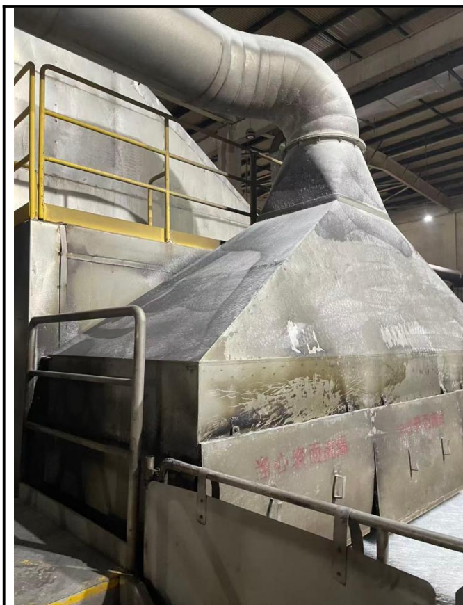
炉前废气收集
