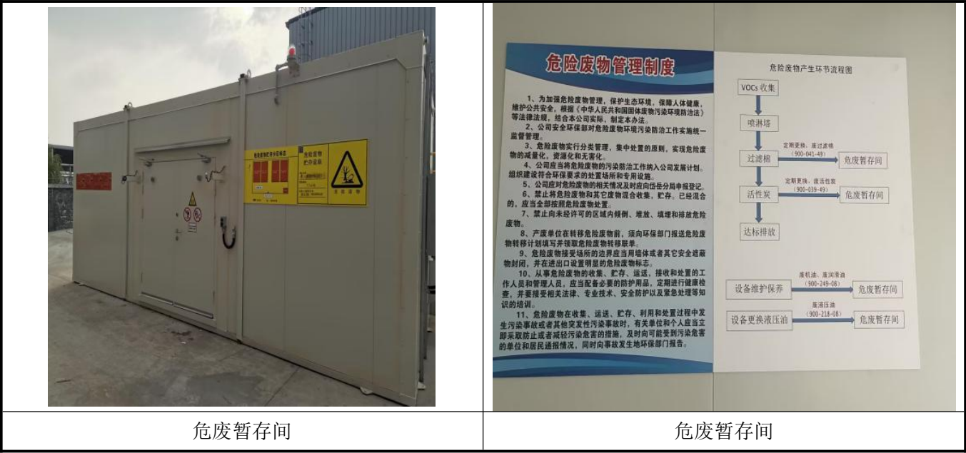
附图 7 项目现场照片
