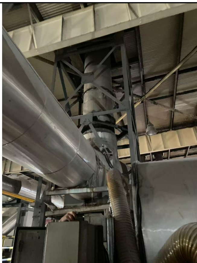
炉中废气收集
